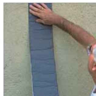
Colocar presionando fuertemente.
