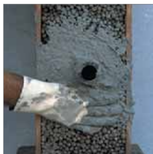
Recoger el agua por un tubo de drenaje fijado con un mortero rápido.
