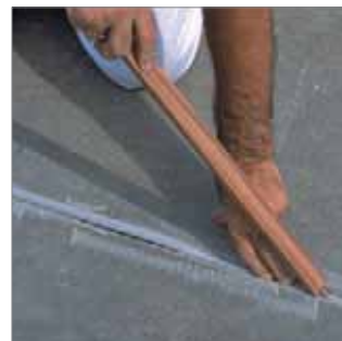
Retacado del Fondo de Junta hasta la profundidad necesaria.
