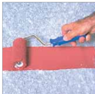
Imprimación del producto diluido (30% de agua).
