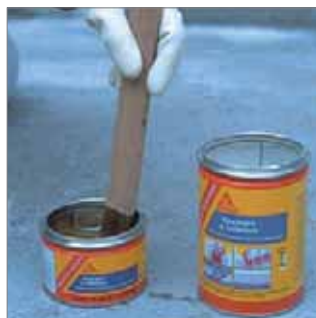
Homogeneización de los componentes.
