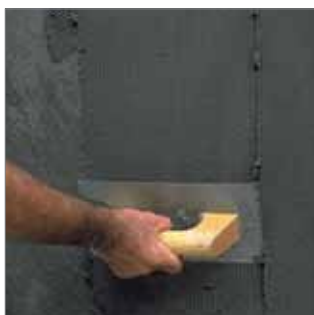
Aplicación de la primera mano con llana.
