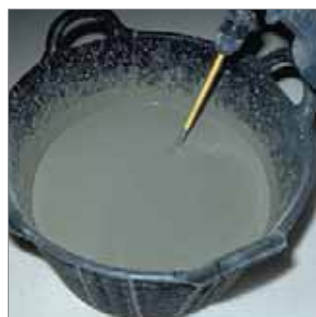
Homogeneización del mortero.
