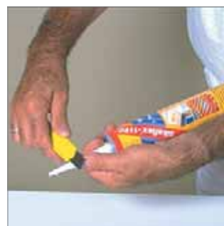
Corte de la boquilla en forma de bisel a 45o.
