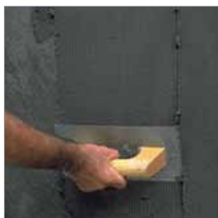
Aplicación de la primera mano con llana.
