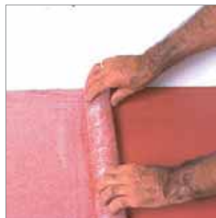
Una vez aplicada la 1.ª mano, se coloca de la armadura de tejido de vidrio, Armafill.
