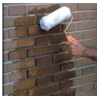
Aplicación de la segunda mano, cuando la primera esté aún fresca
