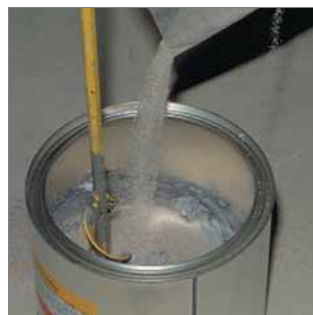
Vertido del componente C sobre la mezcla A+B.
