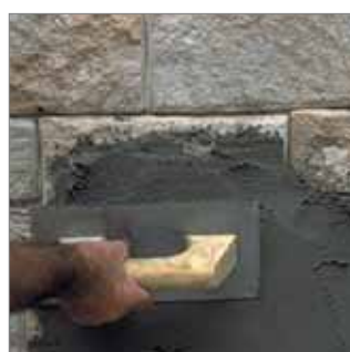
Aplicar la primera mano del producto muy fluido y una segunda mano hasta 2 cm. de espesor total
