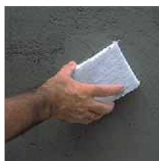
Terminación con un fratás de madera.
