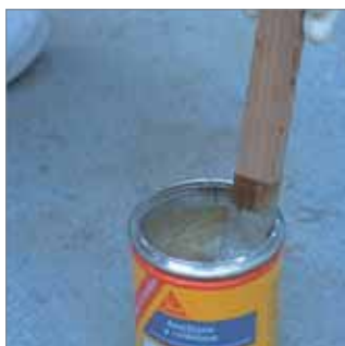
Homogeneización completa.
