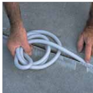
Colocación del Fondo de Junta Sika.
