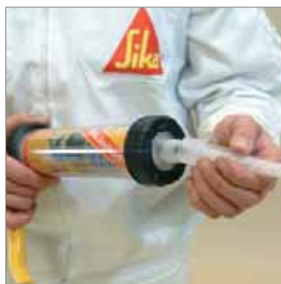
Se limpia la salida y se coloca la boquilla.
