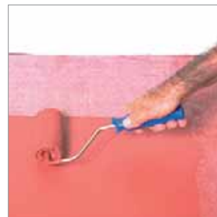
Aplicación de las siguientes capas.
