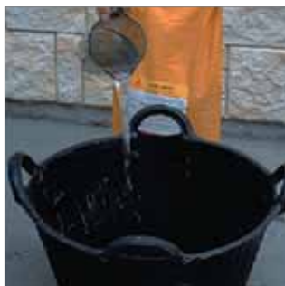
Vertido del agua de amasado en un recipiente de fondo y boca ancho.
