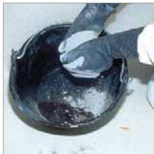
Vertido del cemento.
