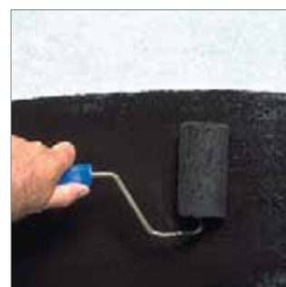
Imprimación con el producto diluido (10-20% de agua).
