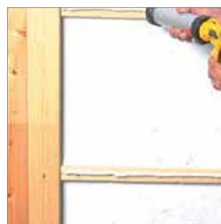
Aplicación del adhesivo.
