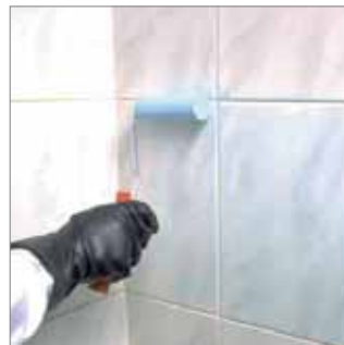
Si fuera necesario se aplicará la imprimación SikaCeram®-20 con objeto de mejorar la adherencia.
