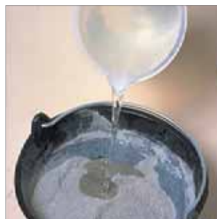
Se añade el agua necesaria para el amasado.
