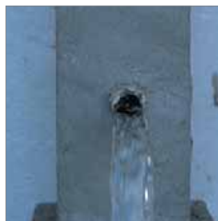
Impermeabilizar el soporte.
