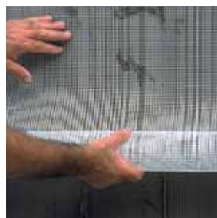
Colocar la malla antialcalina, (opcional).
