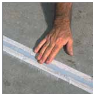
Alisado de la masilla con la mano humedecida en agua jabonosa y eliminación de la cinta autoadhesiva
