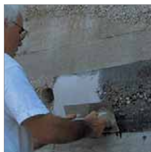
Aplicación del producto sobre imprimación fresca.
