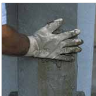
Taponar la vía de agua.
