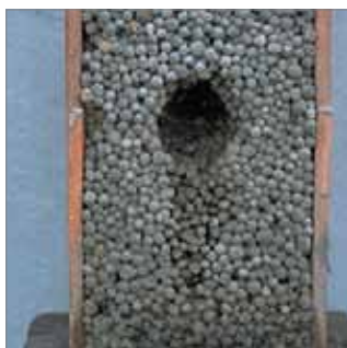
Estado del soporte.
