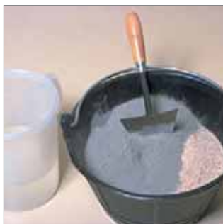
Preparación del mortero: mezcla de cemento y arena.
