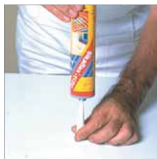
Perforación del cartucho.
