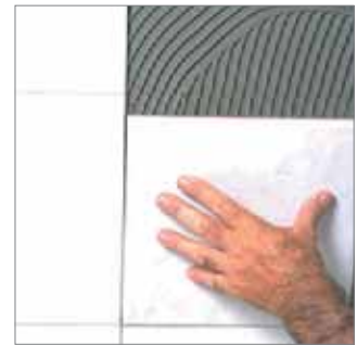
Colocación de la plaqueta.
