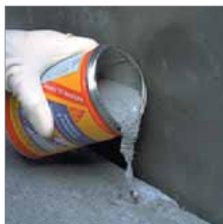
Vertido del mortero.
