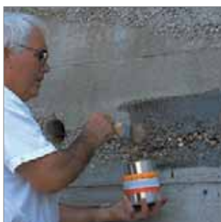
Imprimación con Sikafloor®-156.
