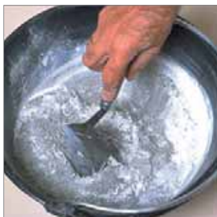
Mezcla del cemento y el aditivo.
