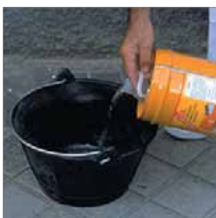
Vertido en un recipiente de fondo y boca ancha.
