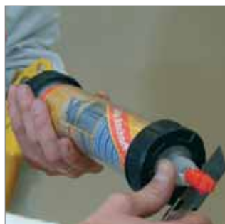
Cortar la boca del cartucho.
