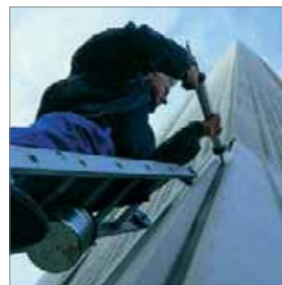
Retacado del Fondo de Junta hasta la profundidad necesaria.
