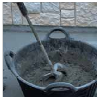
Homogeneización de la mezcla.
