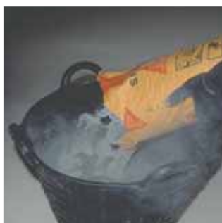
Vertido del producto a la cantidad necesaria de agua de amasado.
