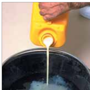
Mezcla del aditivo y el agua.
