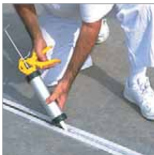
Aplicación de la masilla.
