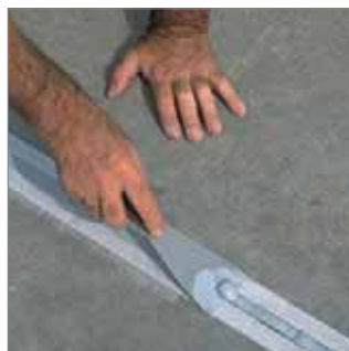
Retirada del exceso de producto.
