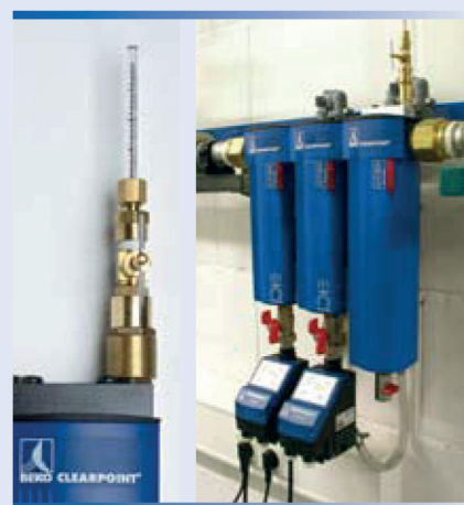
CLEARPOINT® Prefiltros modelos F y S con purgador de condensados BEKOMAT® 20 FM, adsorbente de carbón activo CLEARPOINT® V con indicador de aceite.
