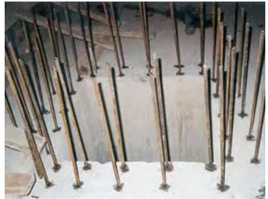
Las resinas de inyección fischer FIS V, FIS VS y FIS VT (vinil éster), así como la resina epoxy FIS EM han sido presentadas hasta aquí como medio de fijación para varillas roscadas, pero existe otro extenso campo de aplicación que es el de la fijación de barras corrugadas, ya sea como anclajes, o bien como esperas de conexión entre estructuras de hormigón nuevas y antiguas.
