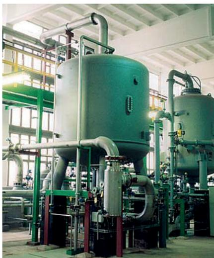
Reactor catalítico para la eliminación de oxígeno del agua de alimentación de calderas
