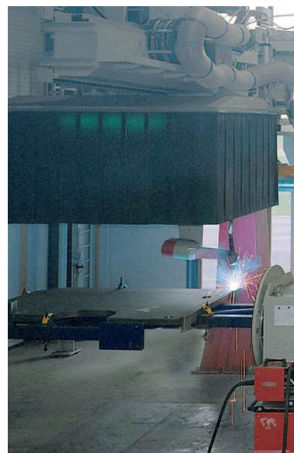
Rendimiento de fusión de hasta 13 kg/h con el arco rotativo bajo CORGON ® He 25 S en soldadura automática de bancadas de máquinas
