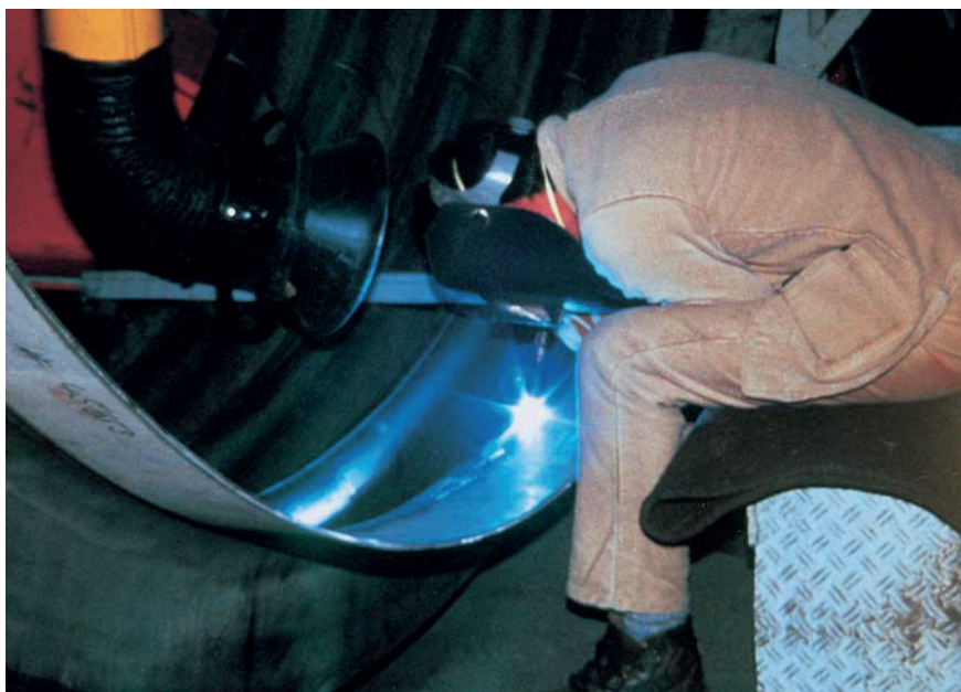
Soldo MAG de aleación resistente a la termofluencia (tobera de escape en motor de reacción), con CRONIGON® He 50 S
