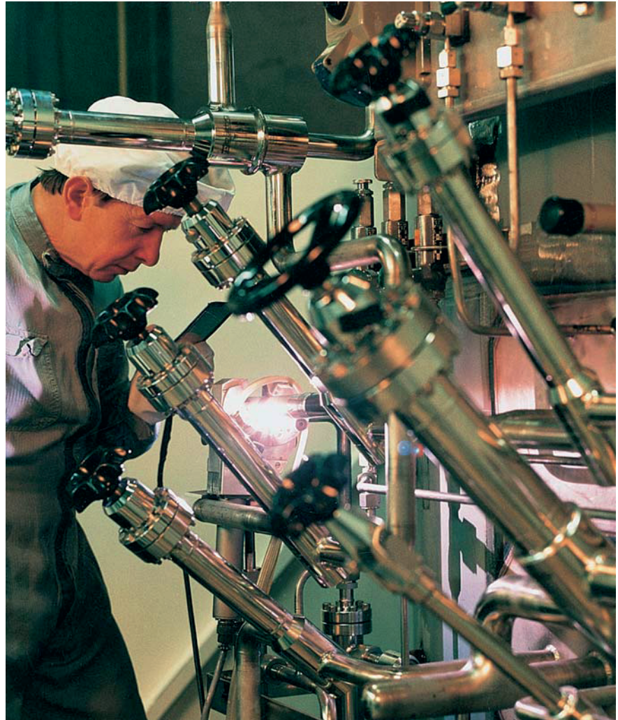
Soldadura bajo protección de gases de formación
