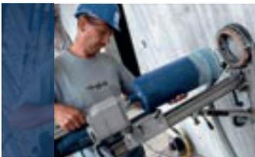
El taladro de diamante GDB 2500 WE Professional perfora a través de hormigón con hierros de armadura, con gran potencia y sin sufrir vibraciones.
