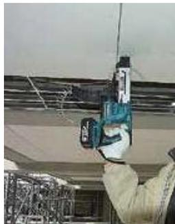
**Atornillados con ristra en tabiquería seca sin esfuerzo, 4.000 R.p.m**
