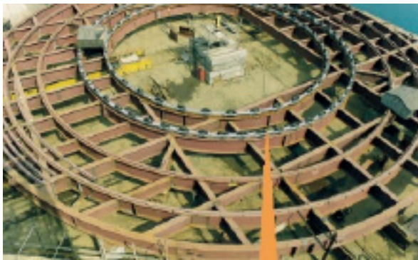
7.600 toneladas y 32 metros de diámetro, girando sobre ruedas de acero de doble pestaña sobre riel, con casquillos autolubricantes. Rueda \phi 450 mm. y ancho de banda 112 mm.
