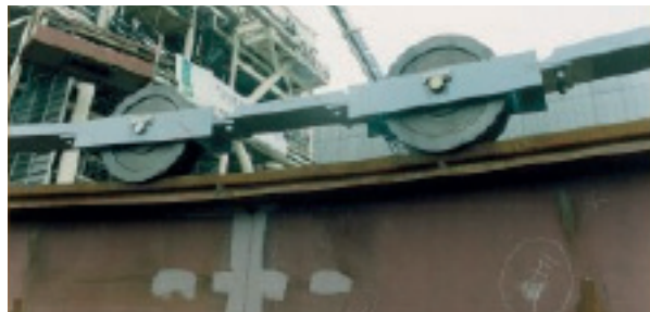
7.600 toneladas y 32 metros de diámetro, girando sobre ruedas de acero de doble pestaña sobre riel, con casquillos autolubricantes. Rueda \phi 450 mm. y ancho de banda 112 mm.
