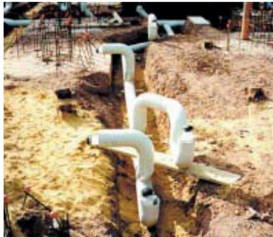
Sistemas de aguas residuales instalados en zonas poco accesibles (por ej.: aeropuertos)
