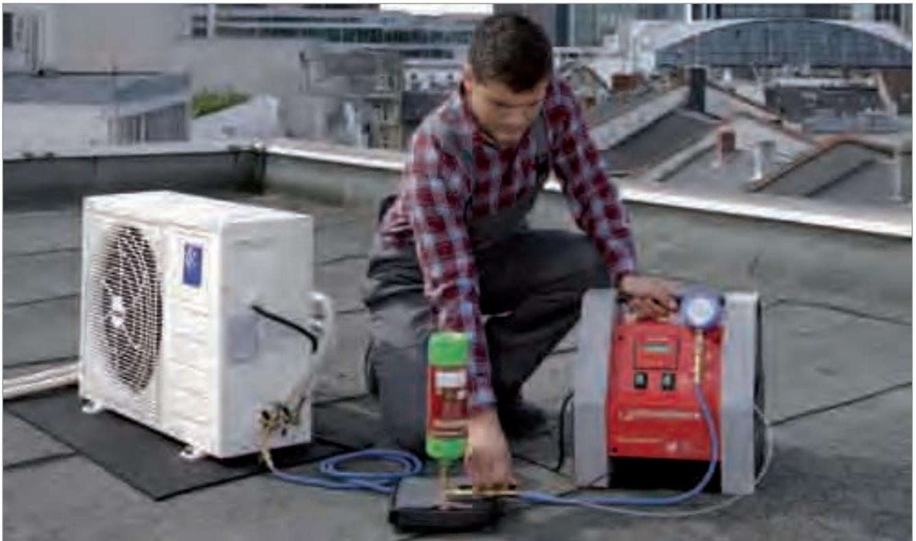
El envío (N° 1000000138) incluye: bomba de vacío de 2 tiempos, 2 manómetros de baja presión, 2 mangueras de presión con válvula de bola 2.500 mm, 2 adaptadores de conexión para tubo (1/4" SAE N° 173205, 5/16" SAE N° 173204), 2 piezas reductoras 1/4" SAE - 5/16" SAE (N° 170016), báscula digital de precisión hasta 100 kg, control automático, interruptores de vacío y presión, aceite mineral (N° 169200)
